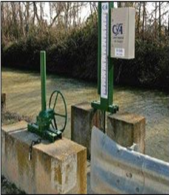
Toma automatizada en el Tomo de Bernal
