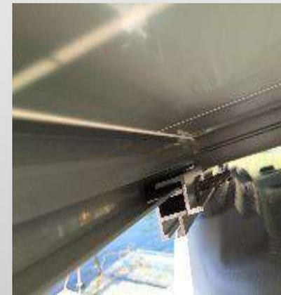
Sistema de fijación sobre el flotador basado en concepto de rail en aluminio
