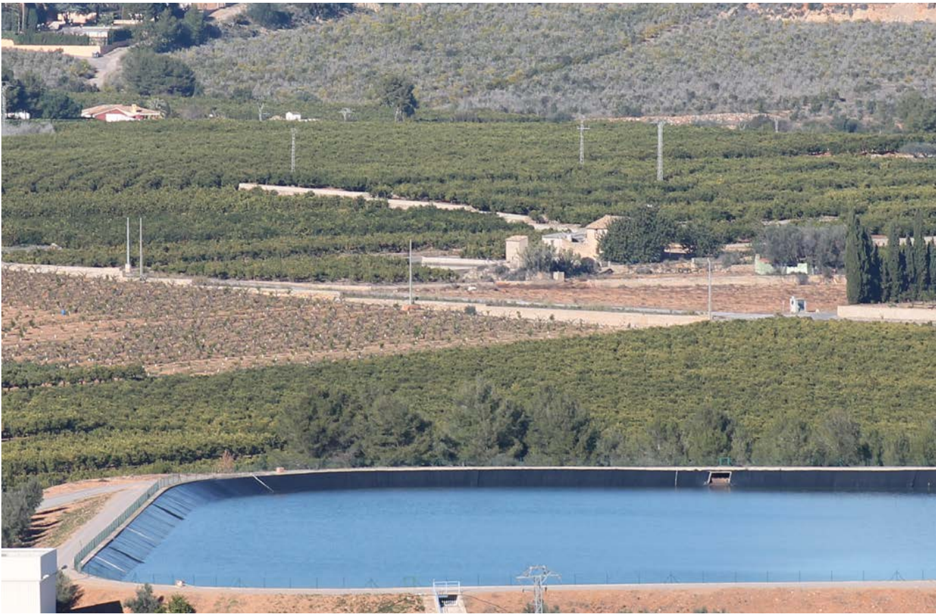
Centro de control y balsa “El Carmen”.
