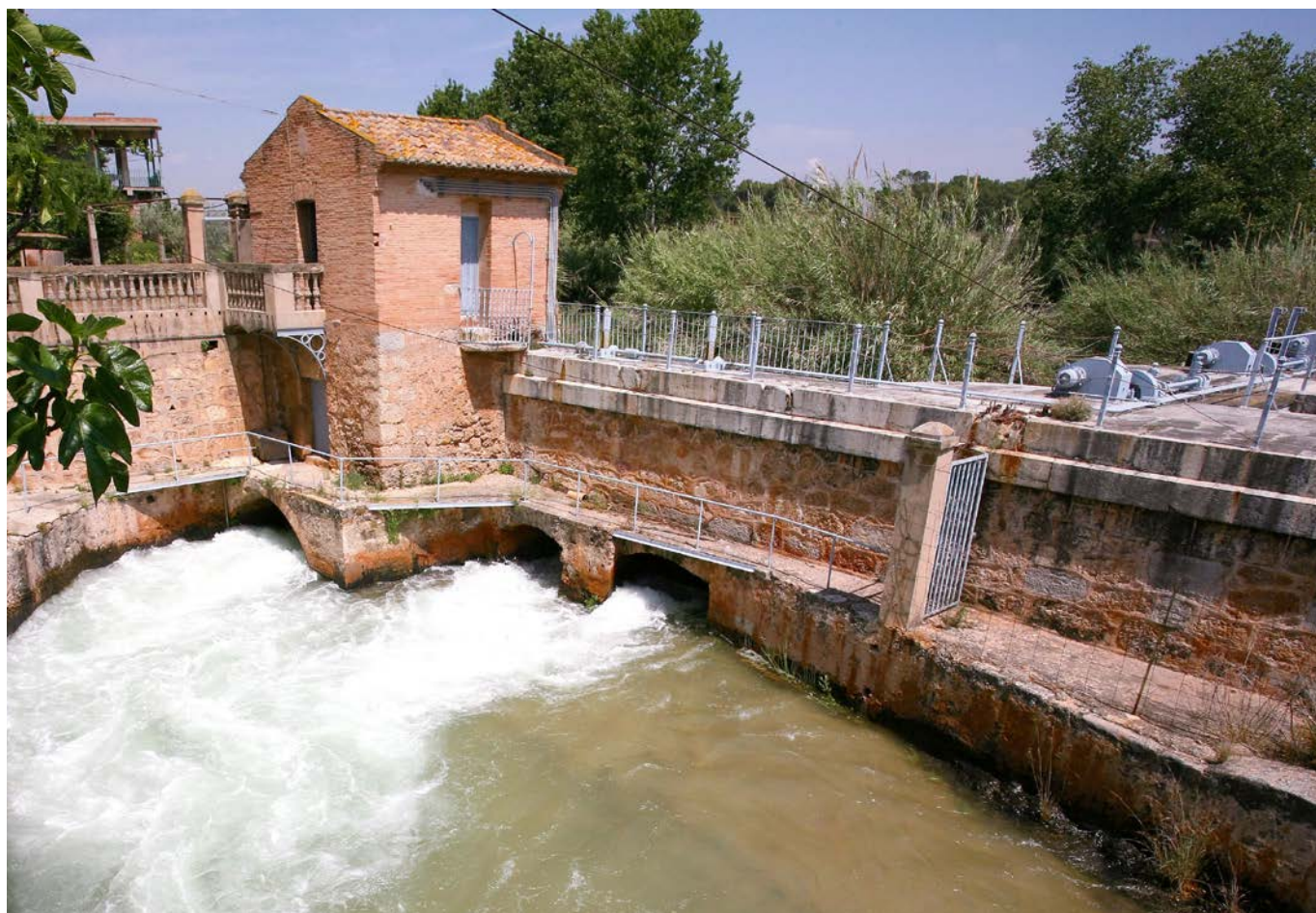
La obra actual se remonta a 1887 como reconstrucción del anterior azud en el siglo XV.
