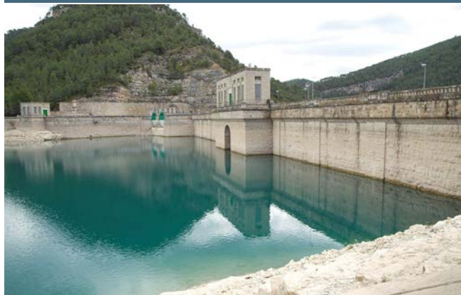
Presa Embalse de Benagéber.
