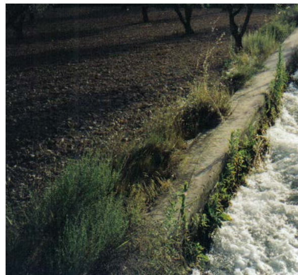
Final Canal Campo Túria.
