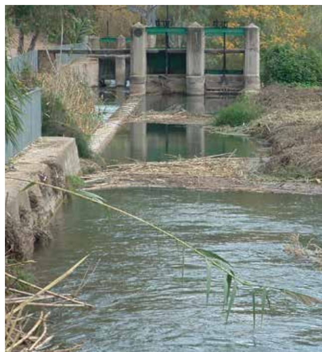
Toma de la Acequia Mayor en el río Palancia, en el término de Sot de Ferrer.
